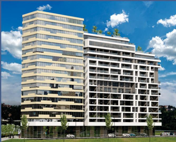
Nosivi armiranobetonski zidovi. Fasadni sistem izvrsnih termo/zvučnoizolacionih svojstava koji se sastoji od fasadnih zidova šuplja blok opeka 25cm i EPS F termoizolacijom debljine 10cm i završnom silikatnom žbukom. Pregradni zidovi su opeka 12cm. Pregradni zidovi između stanova su od armiranog betona debljine 20cm ili od opečnih blokova debljine 20cm. Zidovi prema
